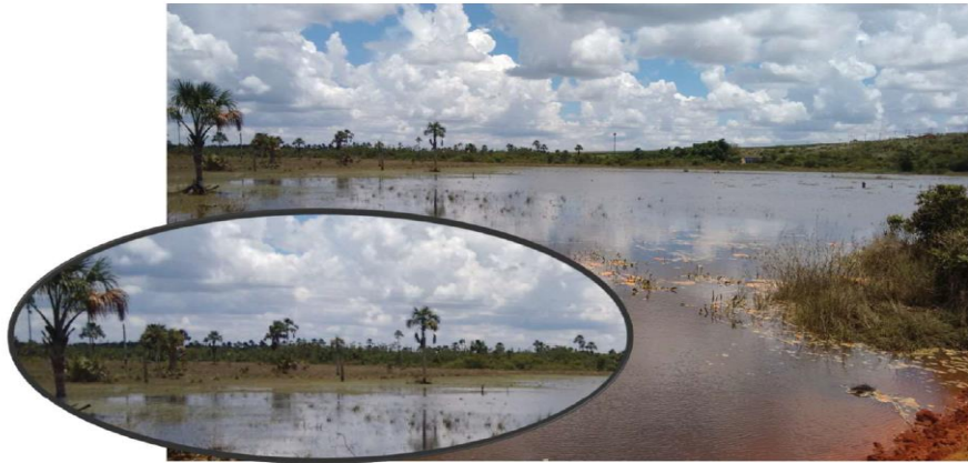
Figura 3. Foto tirada na vistoria no dia 06/12/2016 em cima do talude da barragem com vista para a área inundada. Destaque para a vegetação encontrada no local da barragem ao término da área inundada (montante), com buritis esparsos entremeados à vegetação herbácea e arbustiva, típico de ambientes de várzea. Fonte: Foto e montagem da SUPRAM
