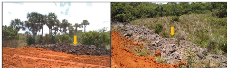
Figura 2. Fotos tiradas na vistoria no dia 06/12/2016 em cima do talude da barragem. A seta amarela indica o solo Gleissolo encontrado no local. Fonte: Foto e montagem da SUPRAM NOR.
