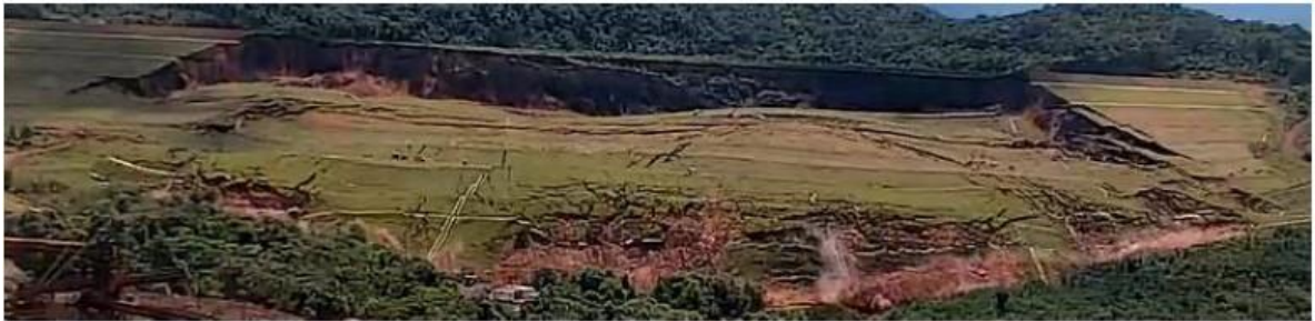
Figura 12 – Vista Frontal do início do rompimento da Barragem 1 - Mina Córrego do Feijão, Complexo Paraopeba - VALE S. A. , Brumadinho/MG. Fonte: B1 – CAM1 – BARRAGEM – 25.01.2019 – 12:28:31
