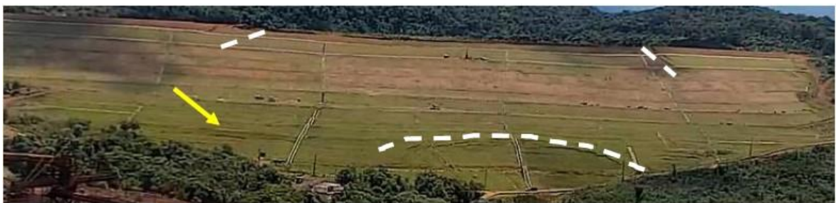
Figura 07 – Vista Frontal do início do rompimento da Barragem 1 - Mina Córrego do Feijão, Complexo Paraopeba - VALE S. A., Brumadinho/MG. Fonte: B1 – CAM1 – BARRAGEM – 25.01.2019 – 12:28:26
