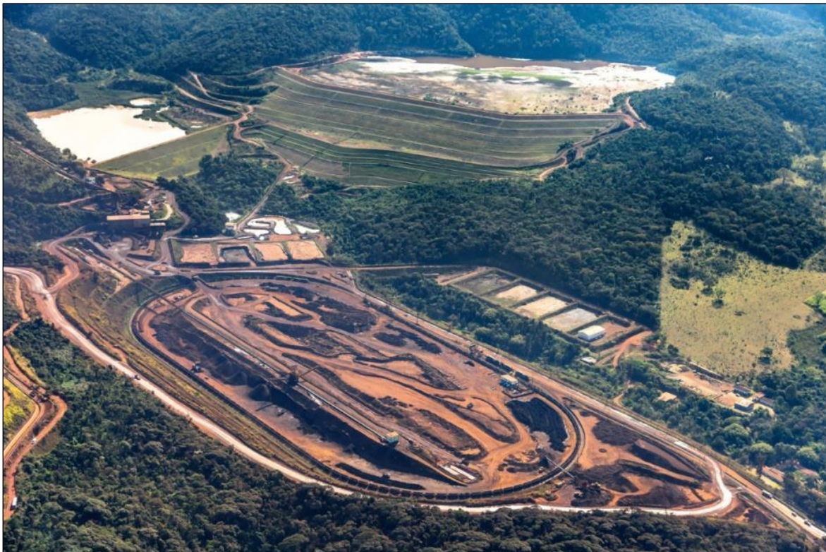
Figura 03 – Vista aérea da Barragem I - Mina Córrego do Feijão, Complexo Paraopeba - VALE S. A., Brumadinho/MG. Fonte: Cálculo de Risco Monetizado – Barragem I – Relatório Técnico – Estudo de Ruptura Hipotética (Dam Break). POTAMOS, Relatório POTVAL02G2-1-TC-RTE-0032, Aprovado em 10.01.2018.
