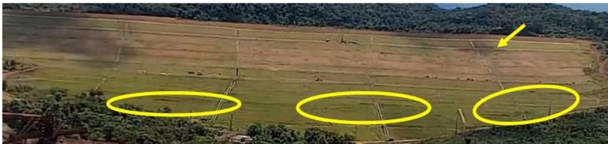
Figura 06 – Vista Frontal do início do rompimento da Barragem 1 - Mina Córrego do Feijão, Complexo Paraopeba - VALE S. A., Brumadinho/MG. Fonte: B1 – CAM1 – BARRAGEM – 25.01.2019 – 12:28:25.
