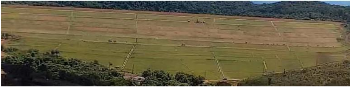
Figura 04 – Vista Frontal, antes do rompimento, da Barragem 1 - Mina Córrego do Feijão, Complexo Paraopeba - VALE S. A., Brumadinho/MG. Fonte: B1 – CAM1 – BARRAGEM – 25.01.2019 – 11:56:01 - que permaneceu até aproximadamente às 12:28:23
