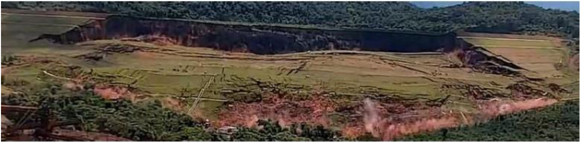
Figura 13 – Vista Frontal do início do rompimento da Barragem 1 - Mina Córrego do Feijão, Complexo Paraopeba - VALE S. A. , Brumadinho/MG. Fonte: B1 – CAM1 – BARRAGEM – 25.01.2019 – 12:28:32
