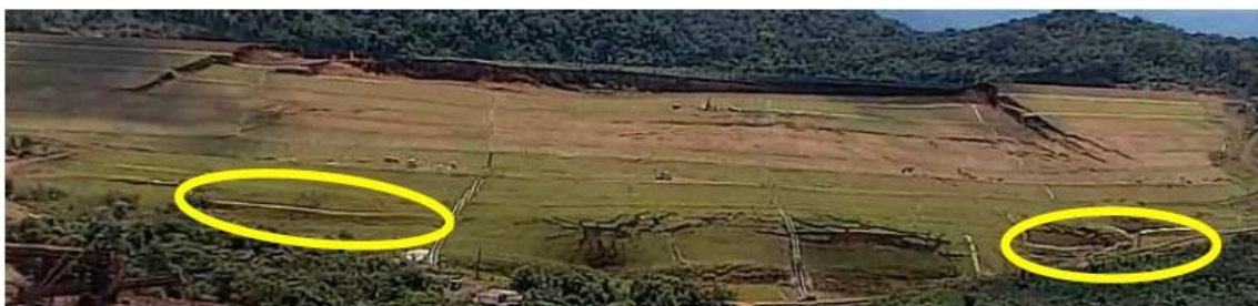
Figura 09 – Vista Frontal do rompimento da Barragem 1 - Mina Córrego do Feijão, Complexo Paraopeba - VALE S. A., Brumadinho/MG. Fonte: B1 – CAM1 – BARRAGEM – 25.01.2019 – 12:28:28
