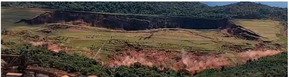
Figura 14 – Vista Frontal do início do rompimento da Barragem 1 - Mina Córrego do Feijão, Complexo Paraopeba - VALE S. A. , Brumadinho/MG. Fonte: B1 – CAM1 – BARRAGEM – 25.01.2019 – 12:28:33
