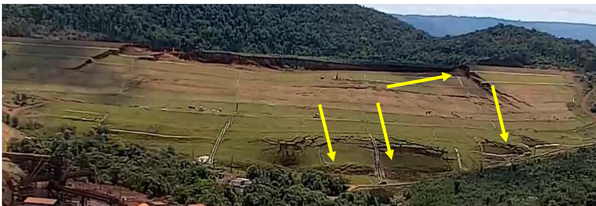
Figura 43. Imagem frontal da Barragem I, captada no momento da ruptura, com setas correlacionando as áreas 4, 14, 15 e 16 identificadas no radar e da Figura 42.
