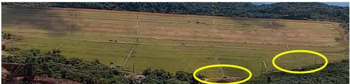
Figura 05 – Vista Frontal do início do rompimento da Barragem 1 - Mina Córrego do Feijão, Complexo Paraopeba - VALE S. A., Brumadinho/MG. Fonte: B1 – CAM1 – BARRAGEM – 25.01.2019 – 12:28:24
