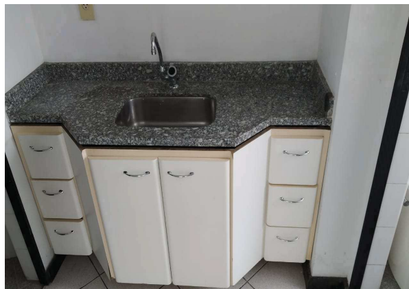
Foto 8: Detalhe da bancada da copa.
